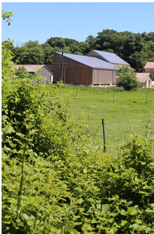
Exemple de bonne intégration de panneaux photovoltaïques - photo : CAUE 41
