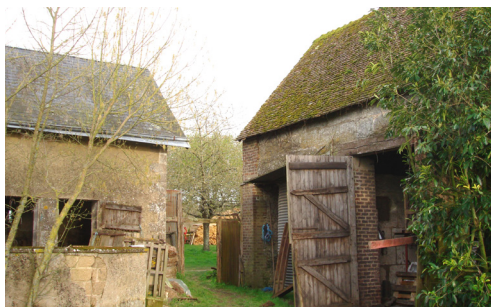
État initial, deux bâtiments distincts
