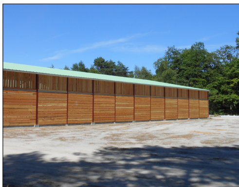
Hangar privé pour plaquettes forestières à Veilleins (41) - photo : chambre d'agriculture 41
